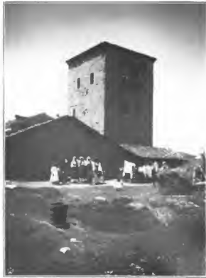
Ashub: Kale (Turm) Seta Aga.
